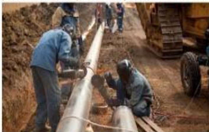
Imagen 5: Cortando ductos con sierra eléctrica.
